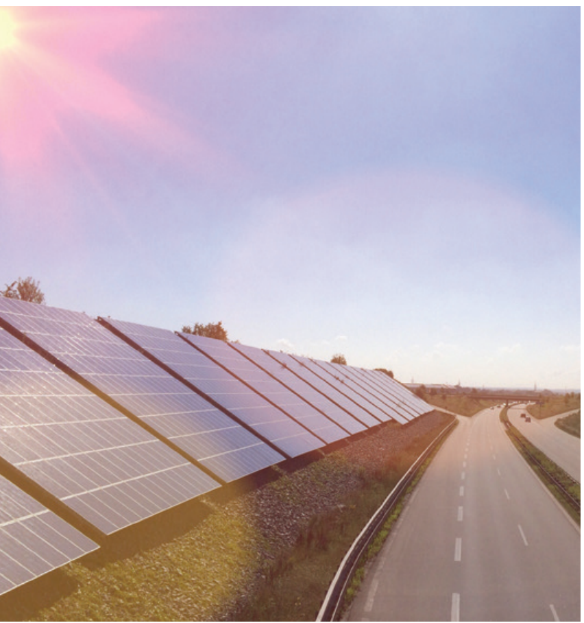
Solaranlage als Lärmschutz auf ca. 1,2 km Länge entlang der A92 bei Freising (D).
