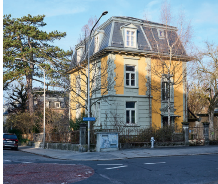
1894 erbaut, ist das Haus der Familie Hutterli heute sogar Minergie-zertifiziert.
